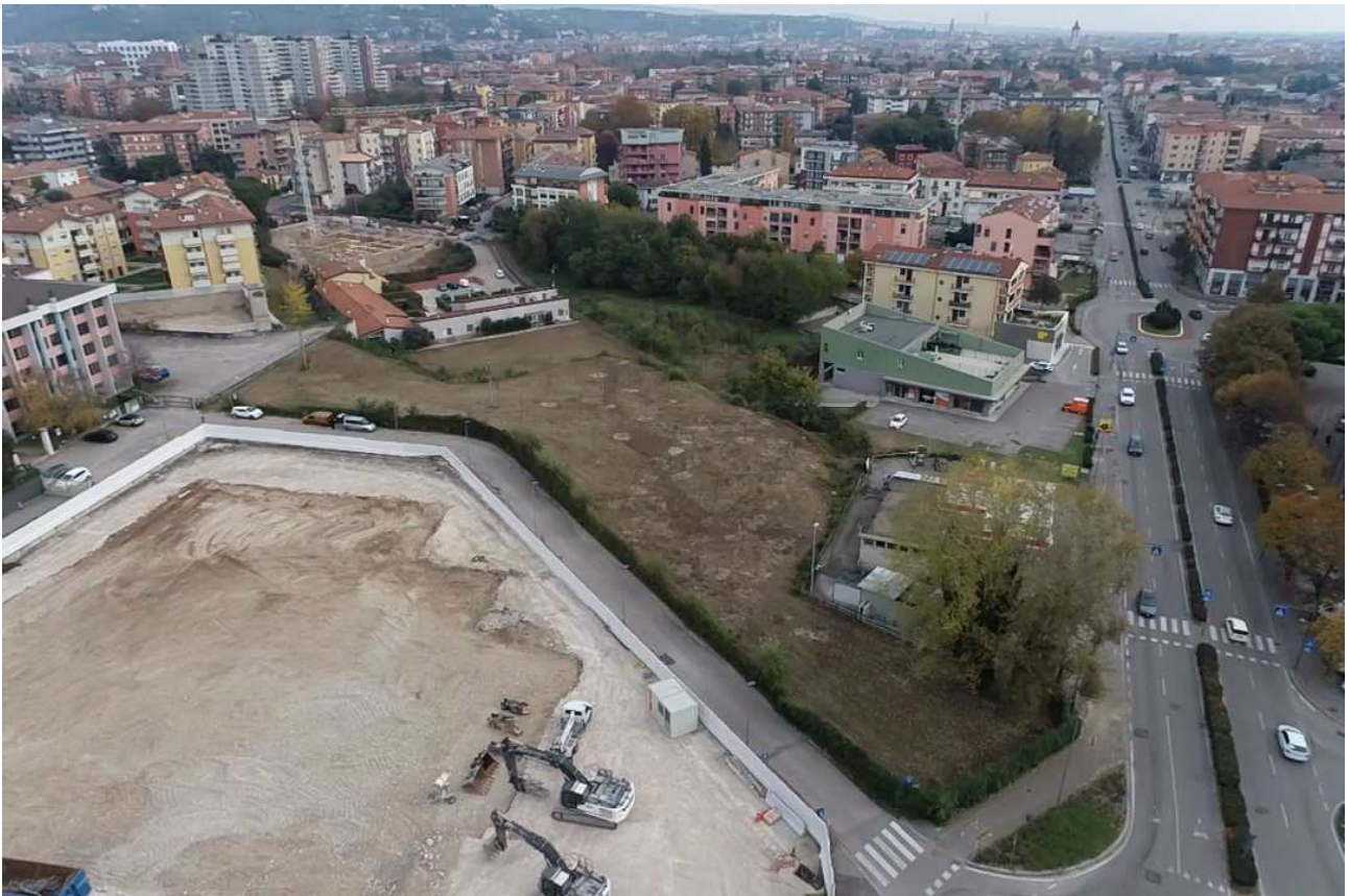
Vista aerea – Ambito di Intervento da sud ovest
